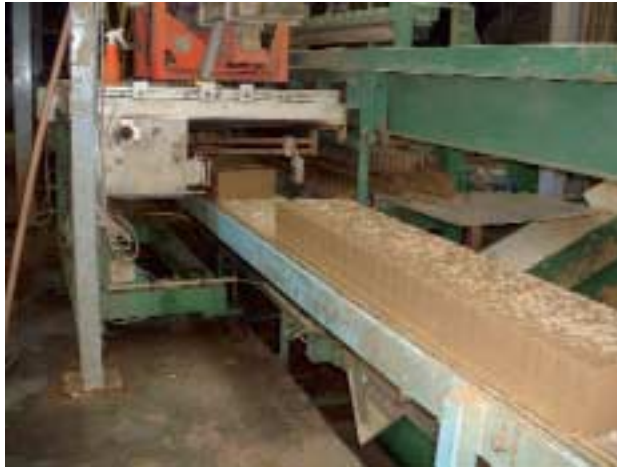
Übergabe der Ziegel vom Harfenabschneider an das Transportband, mit Besandung Transfer of bricks from the multiple-wire cutter to the conveyor belt, incl. sanding
