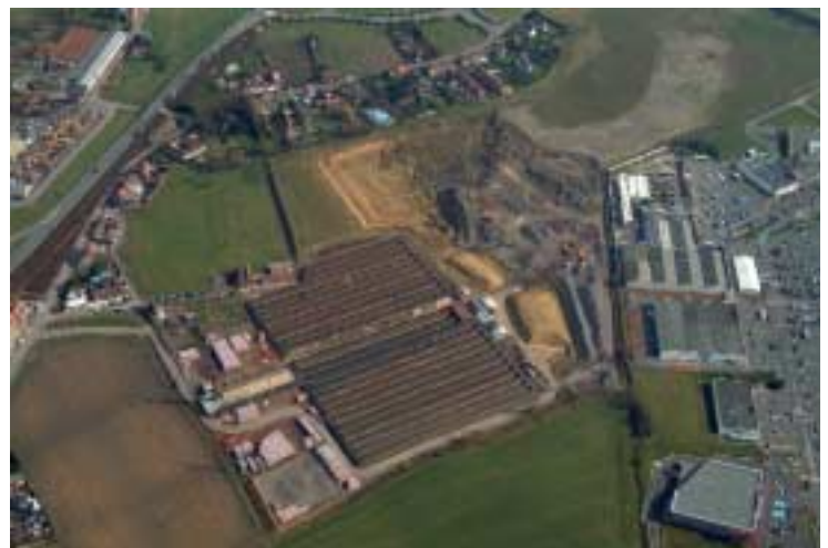
Überblick über den Standort vor dem Umbau General view of the site before the conversion
