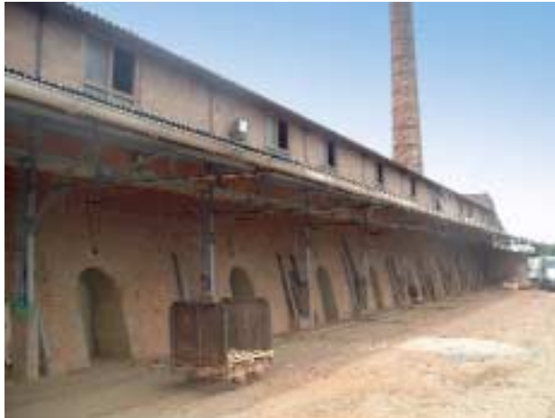
Seitenansicht des Hoffmann-Ofens Side view of the Hoffmann kiln
