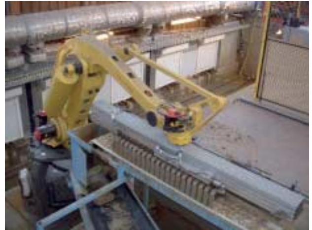
Übergabe der Ziegel an den Roboter mit Positionsbestimmung über Laserabstandssensoren Transfer of bricks to the robot, with position monitoring via laser displacement sensors
