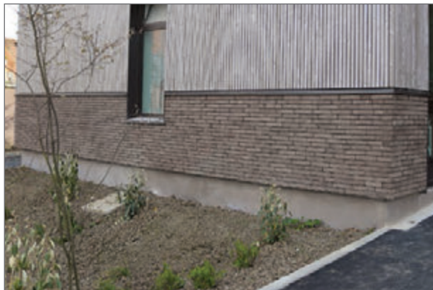
Mise en oeuvre sur fondations ou cordeau béton
