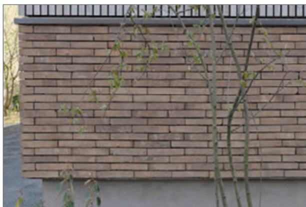
Mise en oeuvre sur console mécanique
