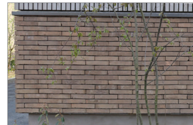
Mise en oeuvre sur console mécanique
